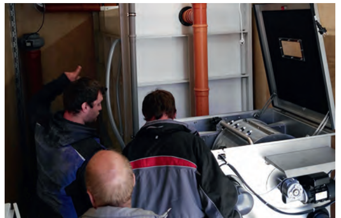
Startup - ready Inbetriebnahme - fertig
