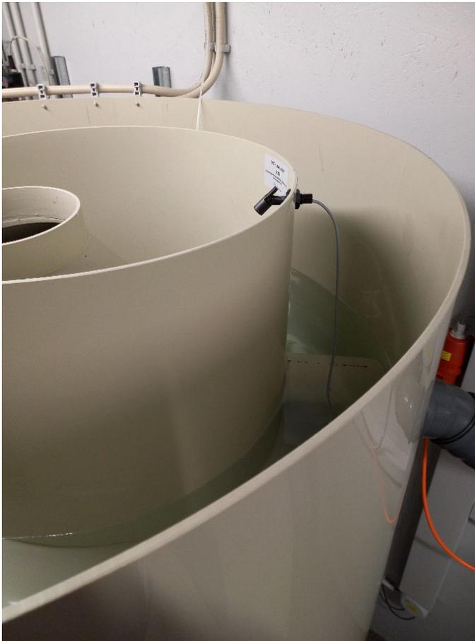
Die ClearFox® DAF ist eine voll automatisierte Einheit. Das zu behandelnde Abwasser wird aus den Ausgleichsbehältern des Kunden oder den ClearFox® Puffertanks der DAF über eine verstopfungsfreie Hohlraumpumpe zugeführt. Der Einsatz von belüfteten Puffern wird für bestimmte Anwendungen empfohlen.
