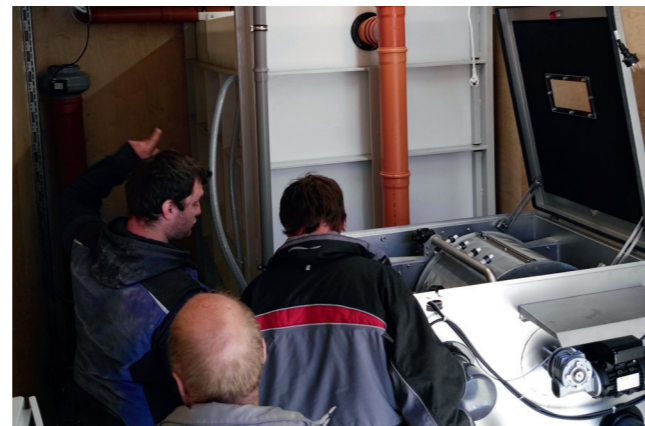
Startup - ready Inbetriebnahme - fertig
